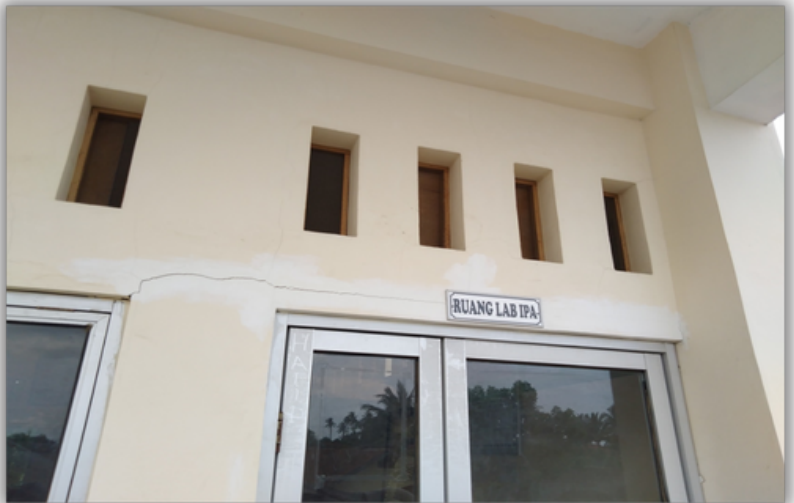
Gambar 26. Tampak Luar Laboratorium IPA MAN 2 Banda Aceh
